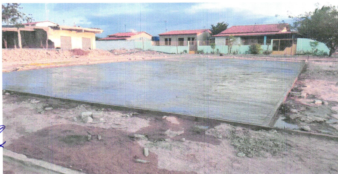
Foto 06 - PAVIMENTAÇÃO EM CONCRETO, COM ESPESSURA DE 7 CM, COM ACABAMENTO FEITO UTILIZANDO ALISADORA DE CONCRETO (HELICOPTERO), INCLUIDO TELA DE AÇO SOLDADA NERVURADA CA60, Q196 (3,11 KG/M 2 ), DIÂMETRO DO FIO 5.0 MM, LARGURA = 2,45 M, ESPAÇAMENTO DA MALHA = 10 X 10 CM, JUNTA DE DILATAÇÃO EM PVC A CADA 2,00 M, CONCRETO FCK = 20 MPA
