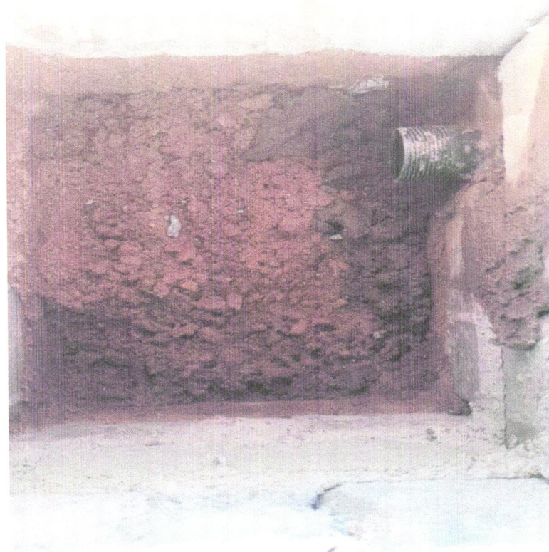
Foto 02 – ELETRODUTO RÍGIDO ROSCÁVEL
