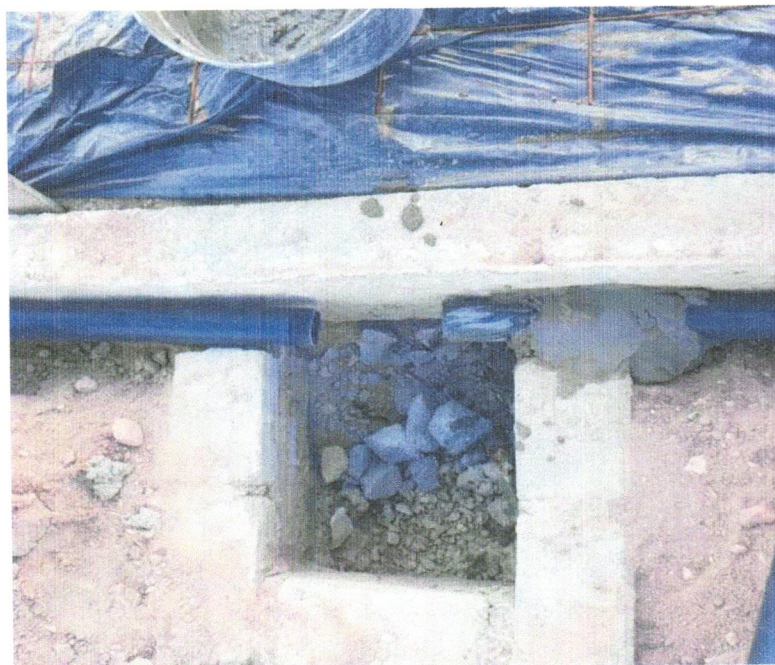
Foto 04 - CAIXA ENTERRADA ELÉTRICA RETANGULAR, EM ALVENARIA COM TIJOLOS CERÂMICOS MACIÇOS, FUNDO COM BRITA, DIMENSÕES INTERNAS: 0,3X0,3X0,3 M. AF_12/2020
