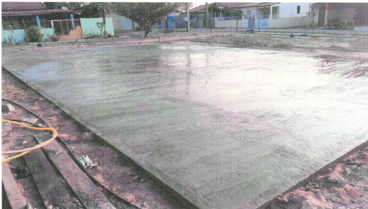
Foto 05 - PAVIMENTAÇÃO EM CONCRETO, COM ESPESSURA DE 7 CM, COM ACABAMENTO FEITO UTILIZANDO ALISADORA DE CONCRETO (HELICOPTERO), INCLUIDO TELA DE AÇO SOLDADA NERVURADA CA60, Q196 (3,11 KG/M 2 ), DIÂMETRO DO FIO 5.0 MM, LARGURA = 2,45 M, ESPAÇAMENTO DA MALHA = 10 X 10 CM, JUNTA DE DILATAÇÃO EM PVC A CADA 2,00 M, CONCRETO FCK = 20 MPA RETIRADA DE MEIO-FIO DNER / ECONOMICO COM EMPILHAMENTO E SEM BOTA FORA
